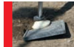
Der Boden muss dem erforderlichen Stützdruck standhalten und darf keinerlei Hohlräume aufweisen.
