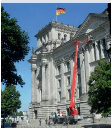
Aus einer ganz neuen Perspektive sahen Ingenieure den Reichstag in Berlin: Mit Hilfe von Gerken Arbeitsbühnen prüften sie den Fassadenzustand des ehrwürdigen Gebäudes auf Risse und losen Putz. Mit der GL 35 G, GL 45 G, GL 58 H Allrad und GL 72 G waren dabei gleich vier Maschinen der Berliner Gerken Niederlassung im Einsatz. Bei schönstem Wetter und dank guter Planung konnte der Einsatz zügig durchgeführt werden.
